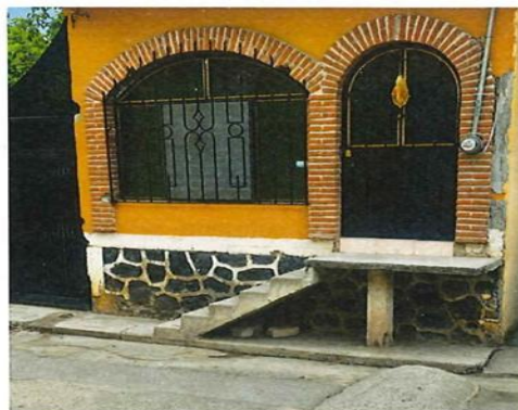
Amacuzac, Morelos. Obstrucción de banqueta con escaleras.
