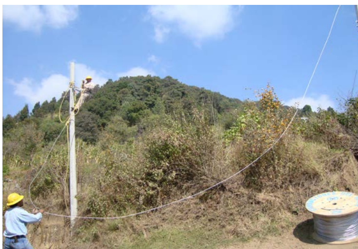
Obra de Electrificación en la localidad de Hueyapan del Municipio de Tetela del Volcán
