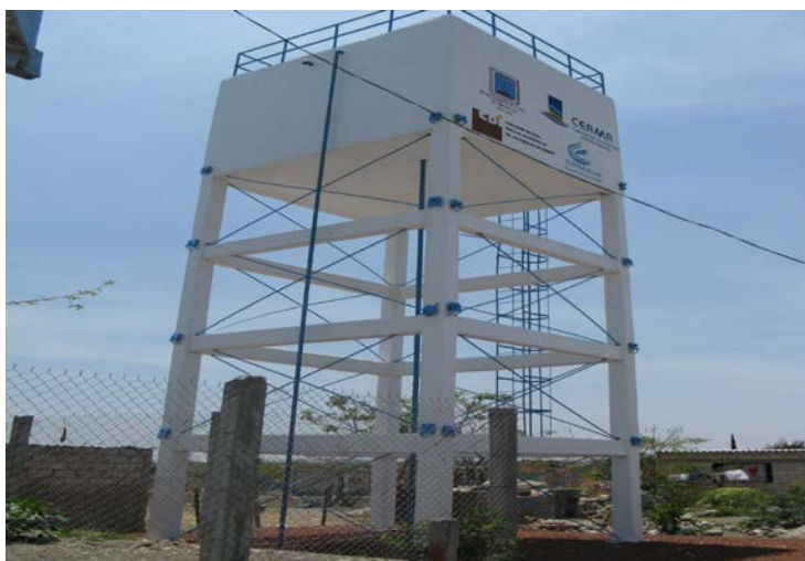
Construcción de Tanque elevado de agua en la localidad de "La Pintora" del Municipio de Xochitepec
