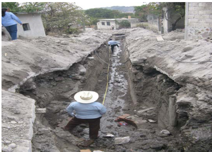
Obra de Drenaje y Alcantarillado en la localidad de Cuentepec del Municipio de Temixco
